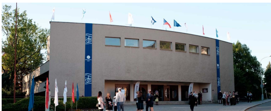
Obr. č. 11 – 14: Původní podoba Rožkovského divadla z r. 1936, interiér hlavního sálu a pohled do předsálí budovy, současný vzhled divadla. Foto: archiv Ing. arch. Karla Blanka
