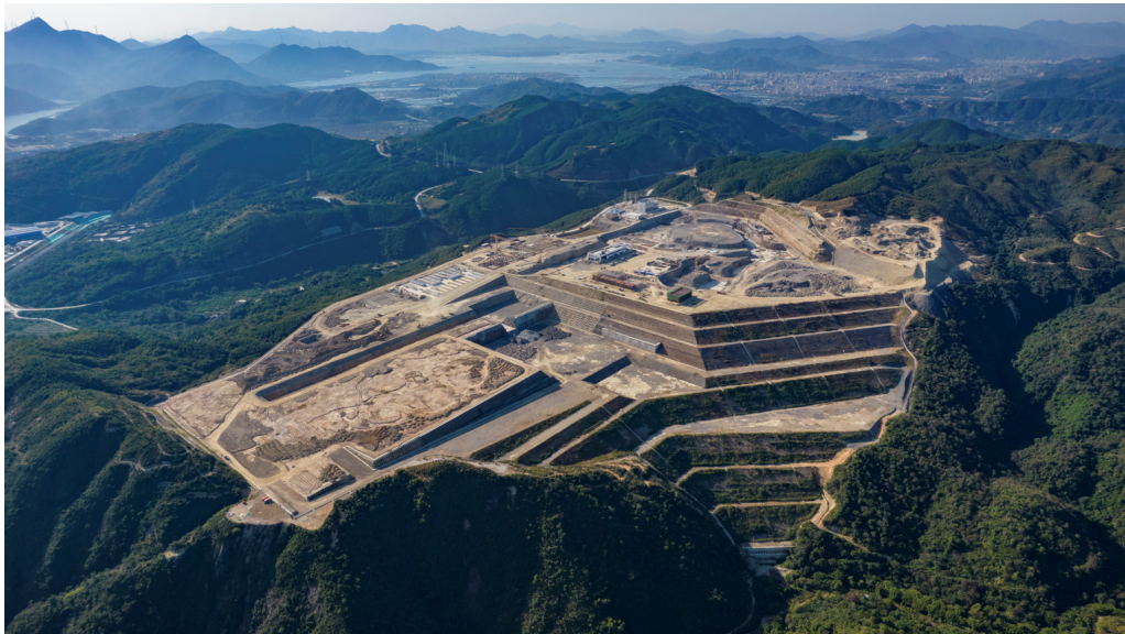
Obr. 3.6: Systém CiADS vo výstavbe [19]
