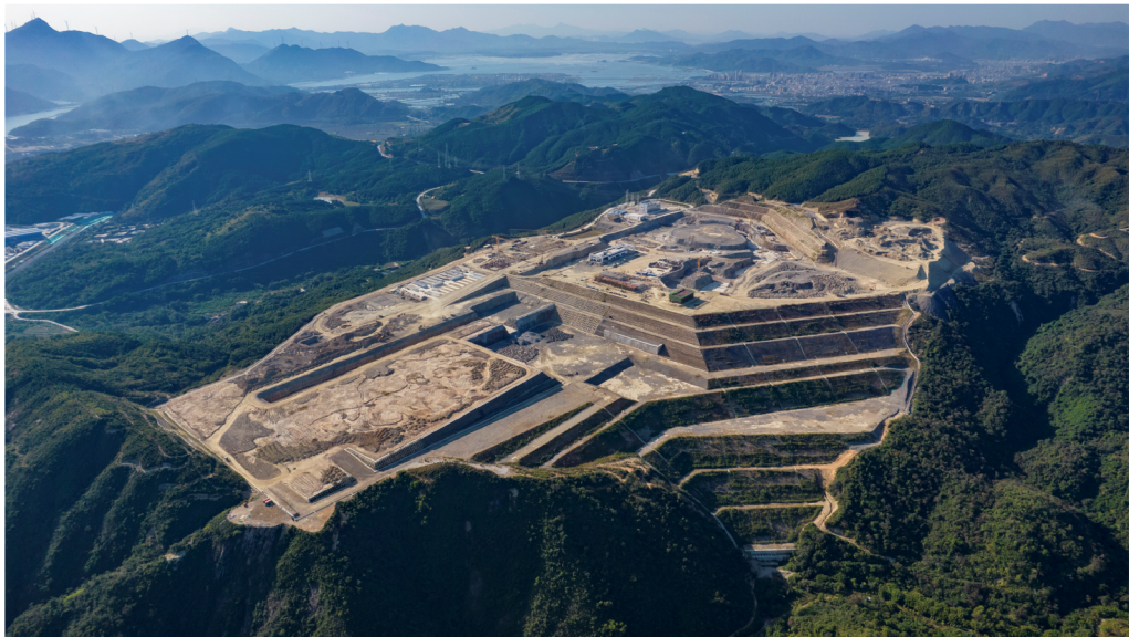
Obr. 3.6: Systém CiADS vo výstavbe [19]
