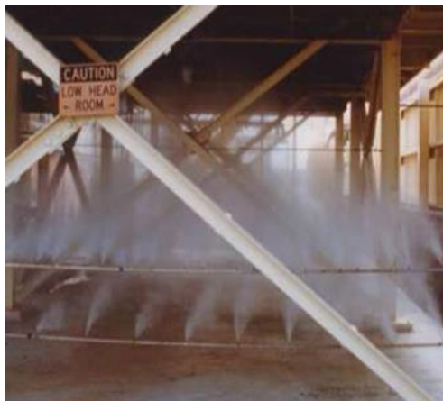
Obr. 3.21: Ukázka několika vrstvého roztřiku vody s kompletním odpadem [3]
