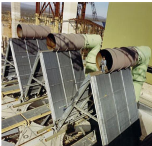
Obr. 1.9: ACC Matimba Power Station ve výstavbě [14]
