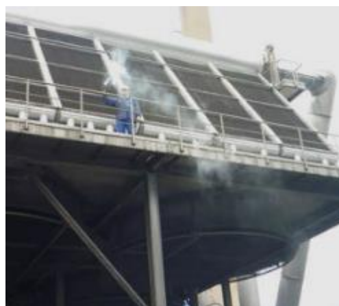
Obr. 3.15: Zjišťování recirkulace pomocí ruční dýmovnice [3]
