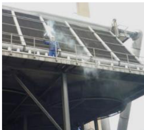
Obr. 3.15: Zjišťování recirkulace pomocí ruční dýmovnice [3]
