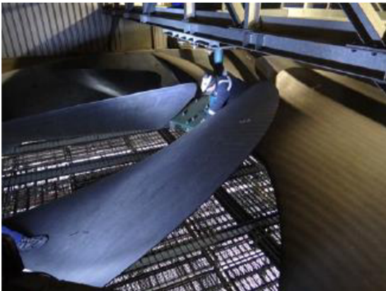
Obr. 3.6: Pohled shora na uložení ventilátoru [3]
