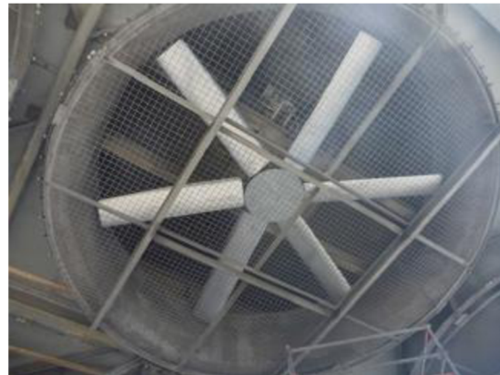
Obr. 3.7: Pohled zdola na uložení ventilátoru [3]
