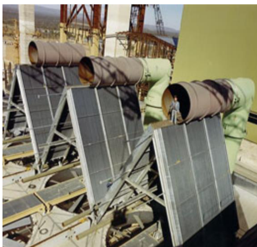
Obr. 1.9: ACC Matimba Power Station ve výstavbě [14]
