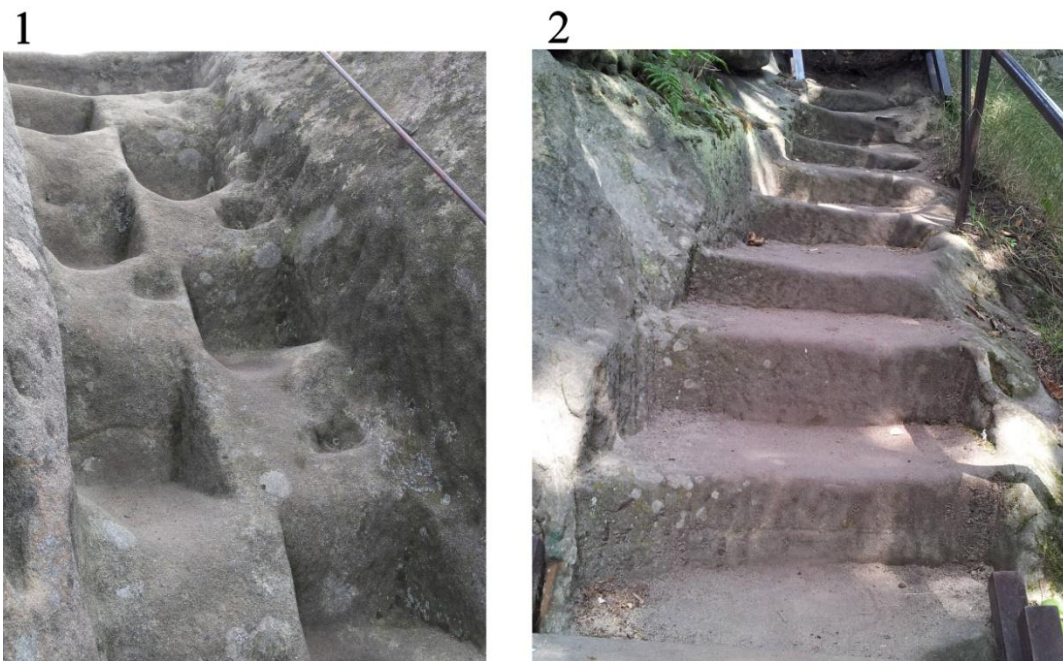
Obr. 9: Schodiště. 1) Nejvýše položené schodiště na hlavní věži; 2) Níže položené schodiště na stejné věži. Foto: autorka práce.
