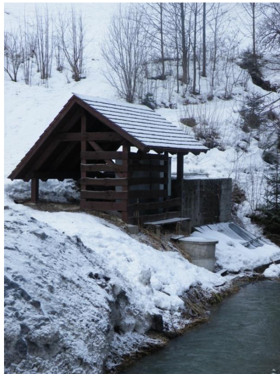
Příloha 3 : Fotografie: Zařízení pro odběr vody.
