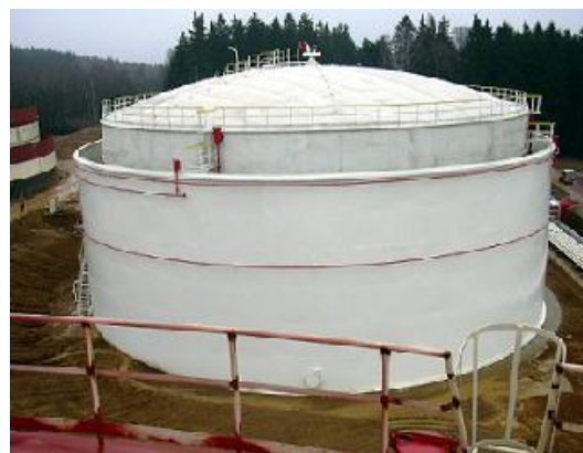
Obr. 1.12 Dvouplášťová nádrž [11]
