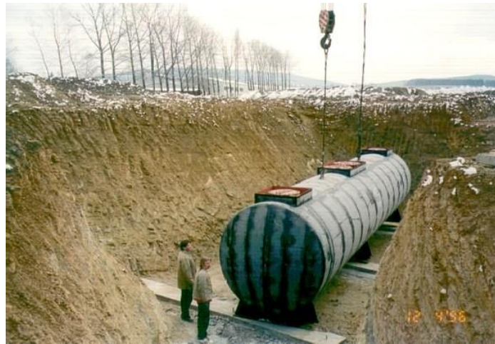
Obr. 1.1 Horizontální válcová nádrž [3]
