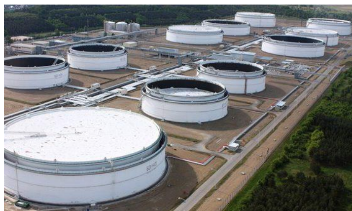
Obr. 1.2 Nadzemní válcové nádrže s plovoucí střechou [4]
