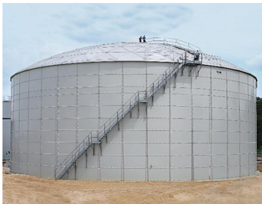
Obr. 1.11 Jednoplášťová nádrž [10]
