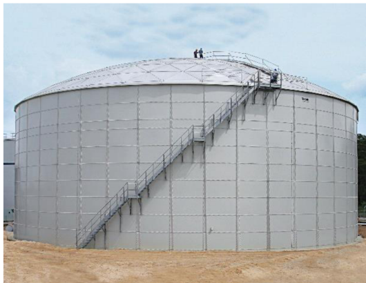
Obr. 1.11 Jednoplášťová nádrž [10]
