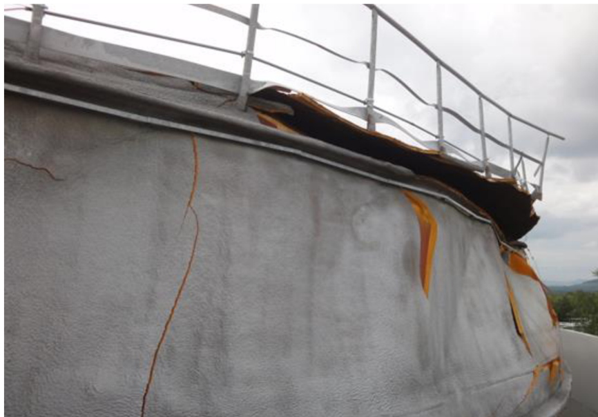
Obr. 2.2 Detail přechodu střecha plášť
