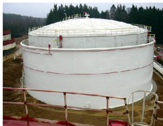
Obr. 1.12 Dvouplášťová nádrž [11]
