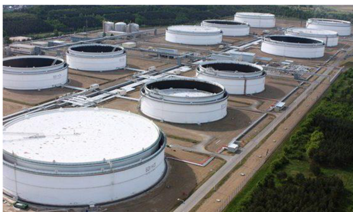
Obr. 1.2 Nadzemní válcové nádrže s plovoucí střechou [4]
