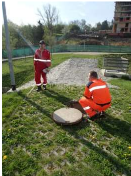
Obr.9 Vstupní šachta na hrázi dešťové usazovací nádrže
