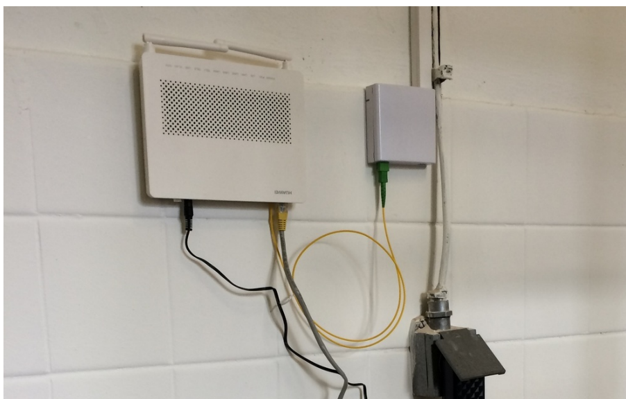
Obr. 3.5: ONT Huawei HG8245H v nasazení u zákazníka.
