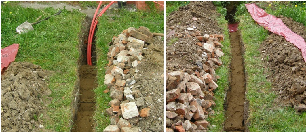
Obr. 7.5: Uložení chráničky 2x 40/33 a 14/10 v pískovém loži.
