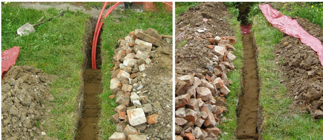
Obr. 7.5: Uložení chráničky 2x 40/33 a 14/10 v pískovém loži.
