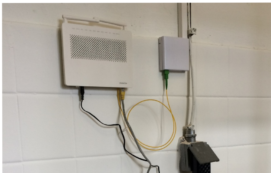
Obr. 3.5: ONT Huawei HG8245H v nasazení u zákazníka.
