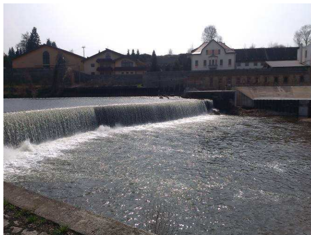
Obr. 19 – jez v obci Kačov (konec úseku č. 1)
