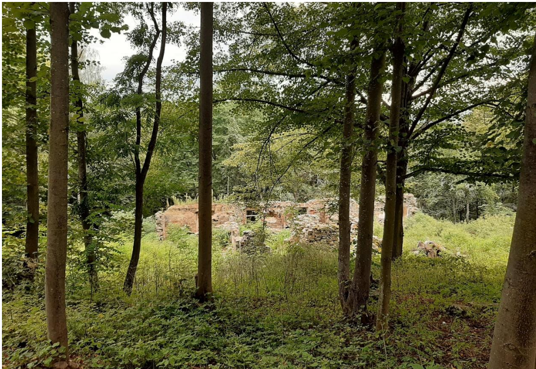
Obrázek 4.16 Zbytek obvodových stěn školy ve svahu pod kostelem (Zdroj: vlastní)
