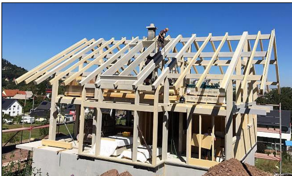
Obrázek 14. Těžký dřevěný skelet [23]
