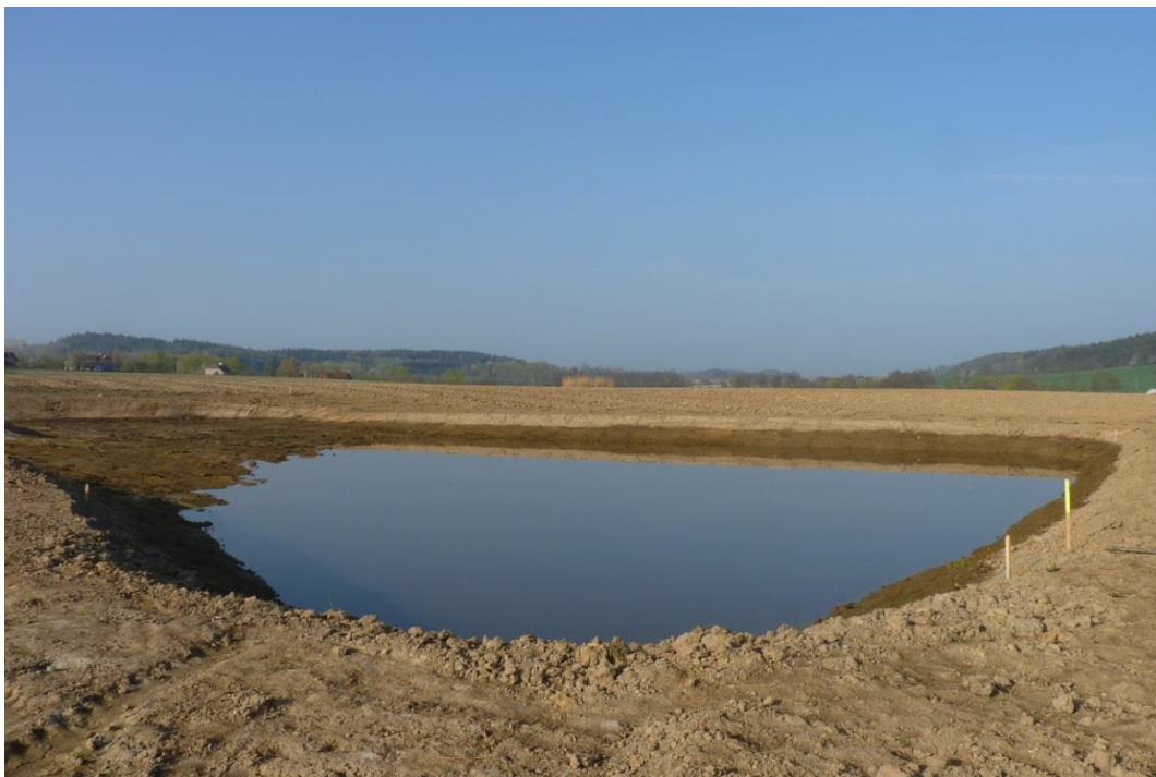
PŘÍLOHA 6 Realizovaná výstavba tůně na Skutečsku
