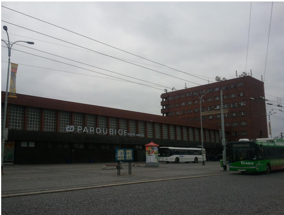
Obr. č. 3: Významný železniční uzel – vlakové nádraží v Pardubicích (Jelínek, 2012)
