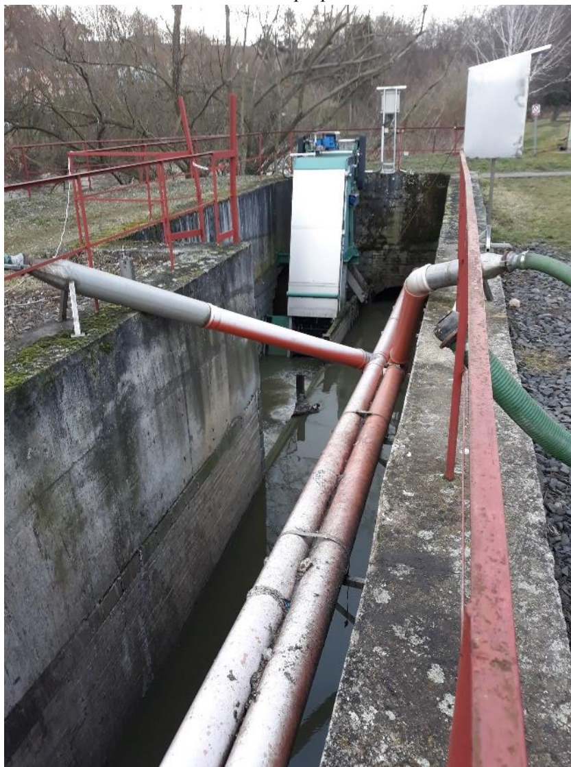
Obrázek 13: Odlehčovací komora s přepadem
