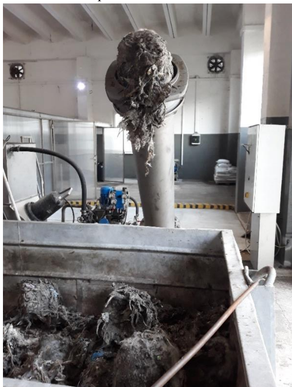
Obrázek 15: Propírací lis shrabků
