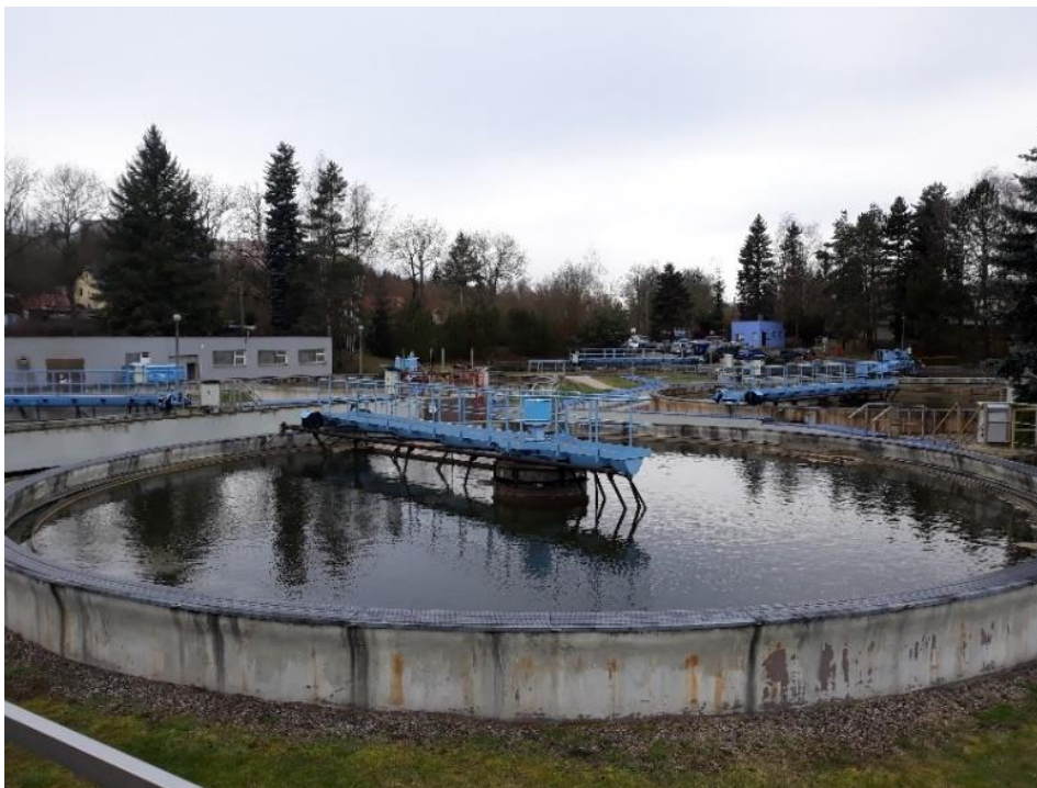
Obrázek 20: Jedna z šesti dosazovacích nádrží
