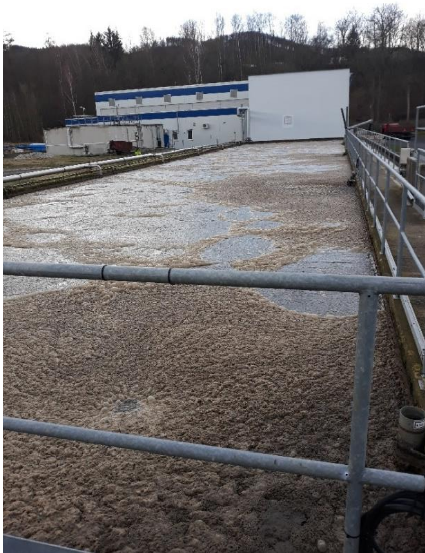
Obrázek 19: Provdzušňovaná nitrifikační nádrž
