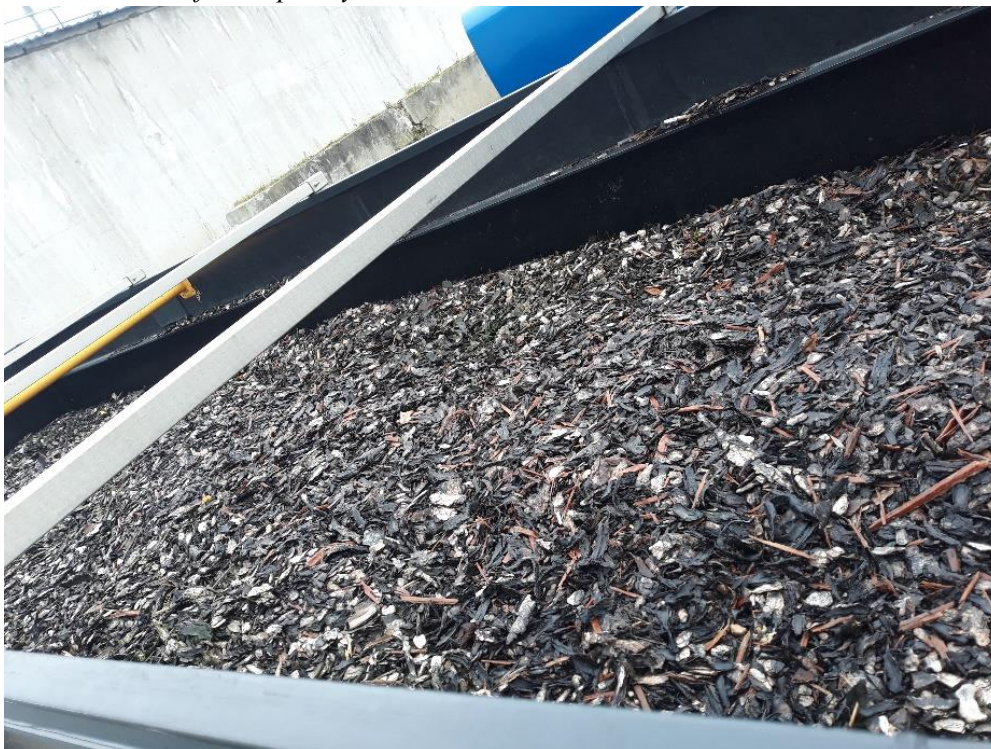
Obrázek 27: Biofiltr naplněný borovou kůrou.
