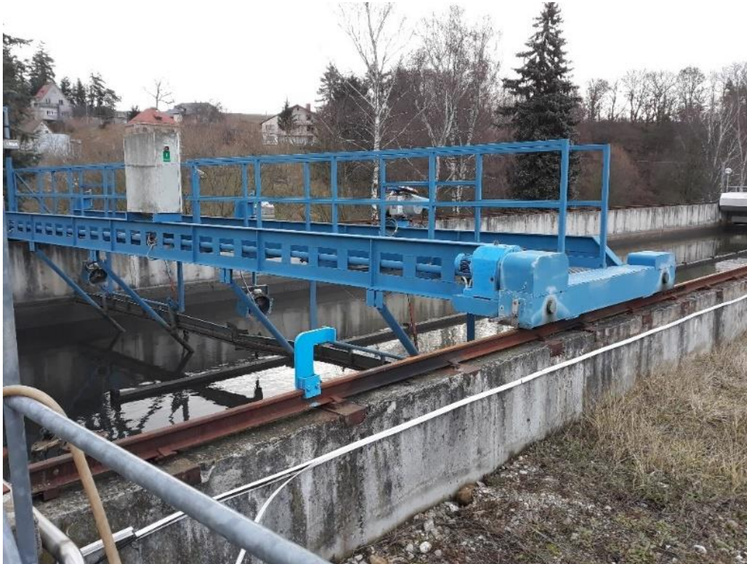
Obrázek 14: Dešťová zdrž zadržující nadměrný přítok v případě velmi intenzivních dešťů
