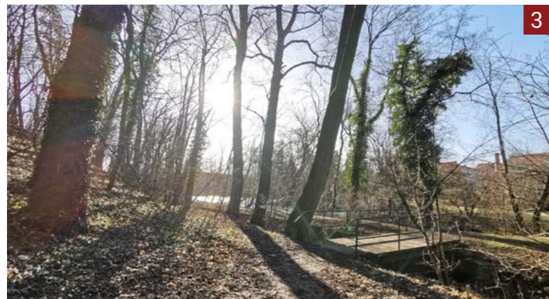
Obr. 142: Zhoršený stav mostku umožňující přechod přes vodní tok Žejdík; absence úprav cestní sítě a nežádoucí zarůstání stromů břečtanem popínavým - Hedera helix (zdroj: autor)
