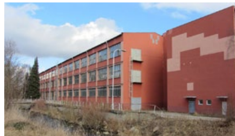
Současná opuštěná budova původního n.p. Jitona
