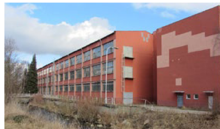
Současná opuštěná budova původního n.p. Jitona
