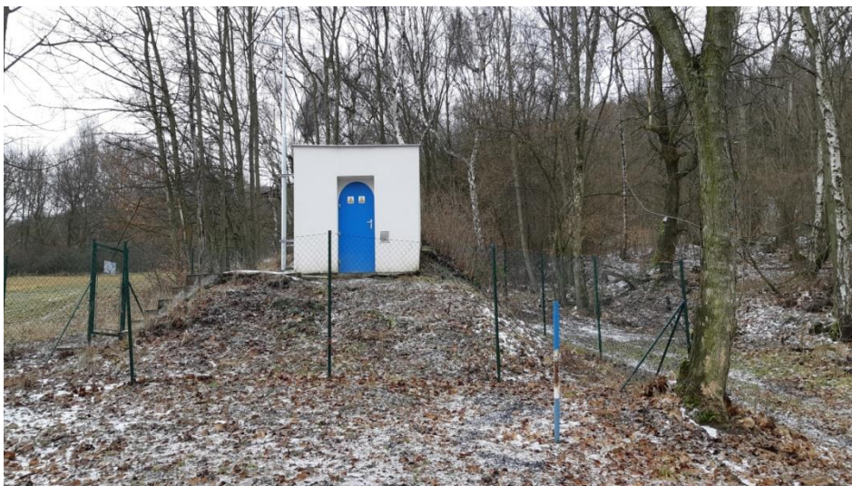
Obr. 20: Foto vodojem Knínice
