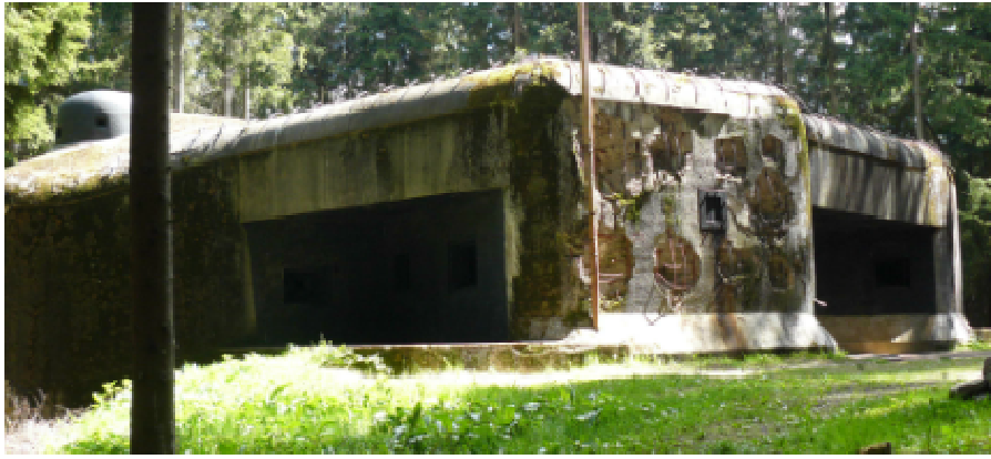
Obr. 20 Pěchotní srub T-S26
