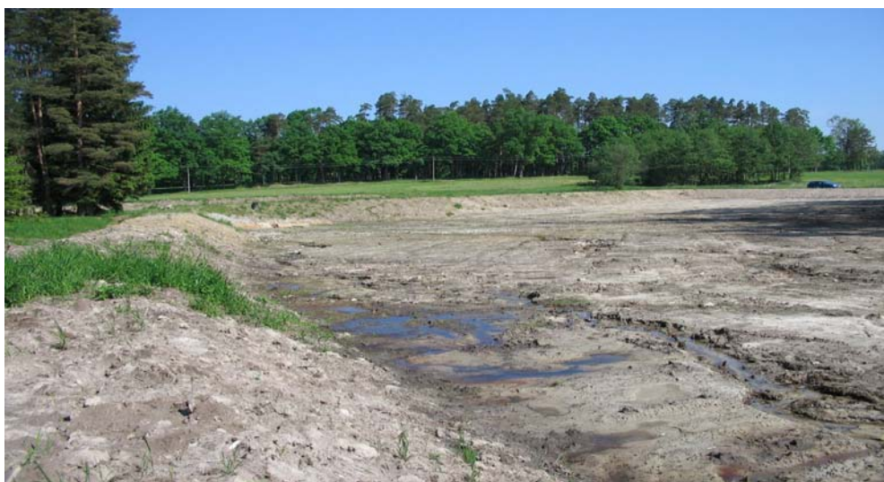
obr. č.4 Výstavba vodní nádrže, při které došlo ke zrušení části zatrubněného toku, k.ú. Hatín
