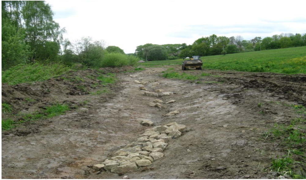
obr. č. 22 Revitalizace Hrobského potoka v k.ú. Kozmice, výstavba nového koryta
