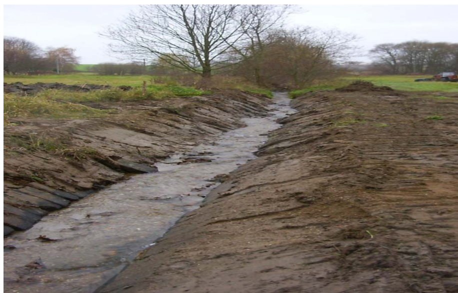
obr. č. 21 Revitalizace Hrobského potoka v k.ú. Kozmice, koryto po odstranění panelů
