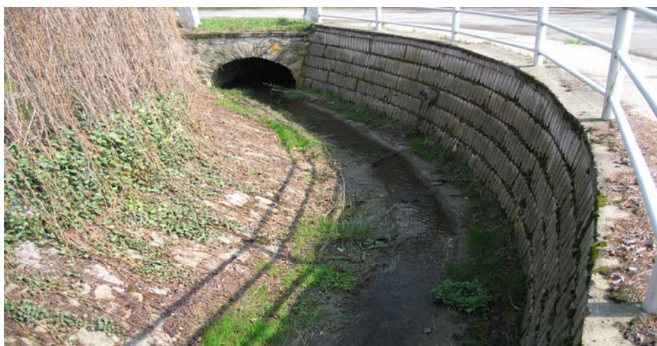
obr. č. 3 Technická úprava Děbolínského potoka v obci Děbolín, dostatečně široké koryto vhodné k revitalizační úpravě v intravilánu
