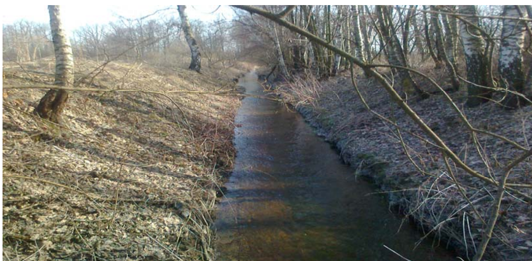
obr. č. 2 Nevhodně provedená úprava (velké zahloubení koryta), koryto vodního toku od rybníka Podlešák do Lužnice, k.ú. Lužnice
