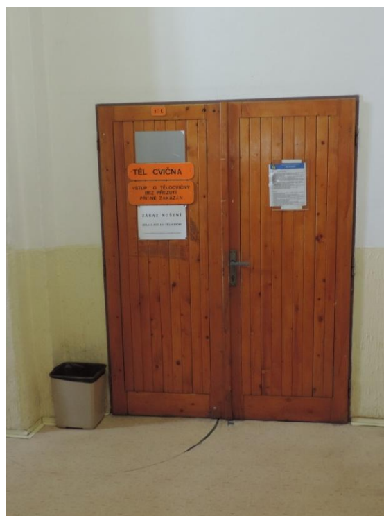
Obrázek 97. Vstup do tělocvičny I.
