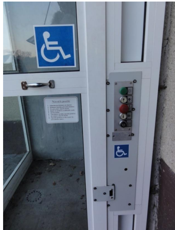
Obrázek 44. Ovládací systém plošiny
