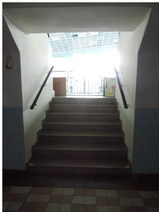
Obrázek 64. Schodiště k tribunám
