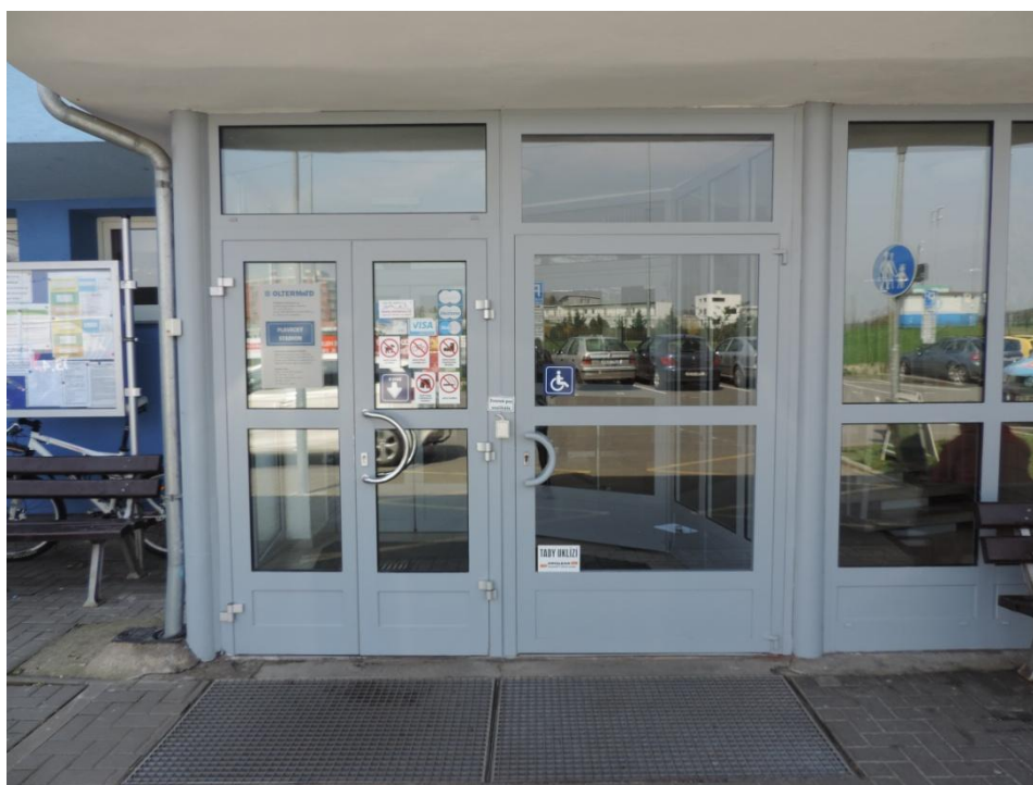
Obrázek 58. Hlavní vstup a bezbariérový vstup pro vozíčkáře
