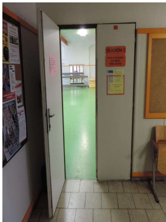
Obrázek 95. Vstup do tělocvičny II.
