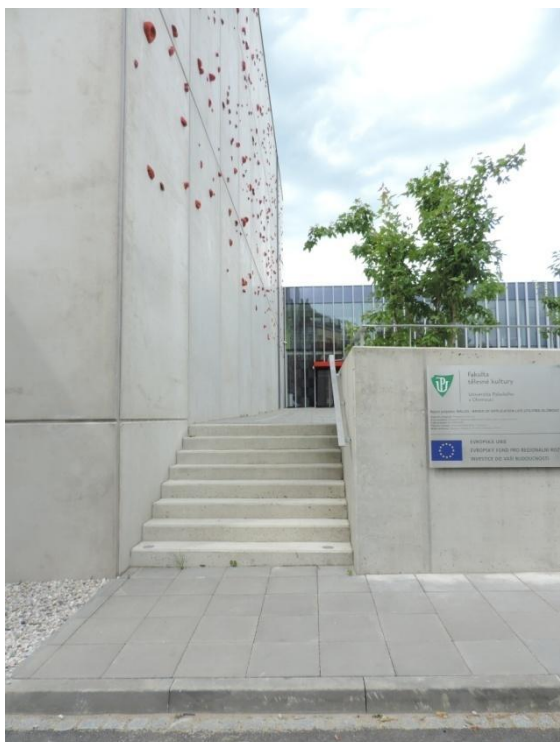
Obrázek 1. Schodiště k hlavnímu vstupu
