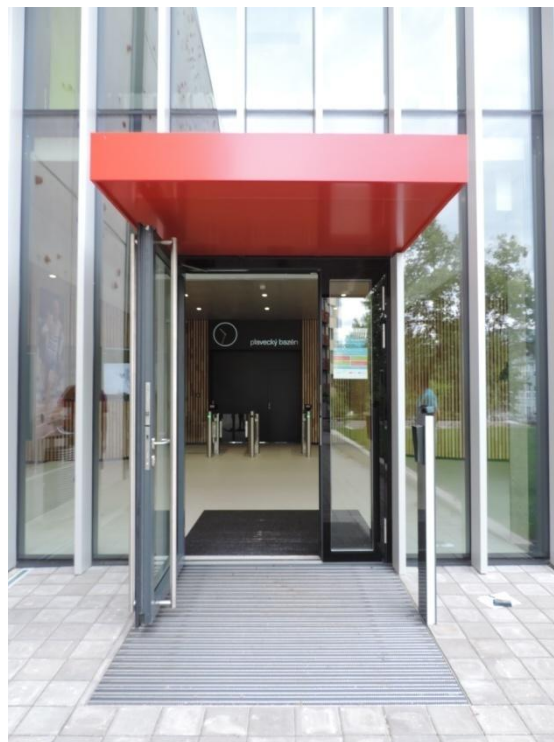
Obrázek 4. Hlavní vchod do budovy
