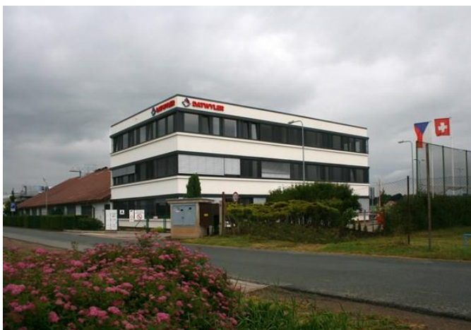
Obrázek 4: Přestavba a nástavba administrativní části haly 1
