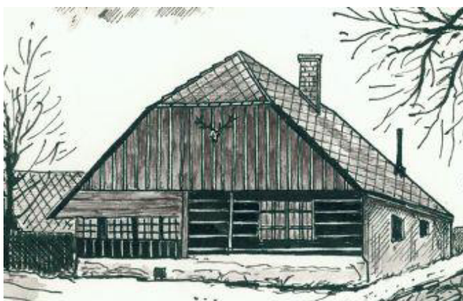
Obr. č. 3: Roubený dům v části obce Dvůr
