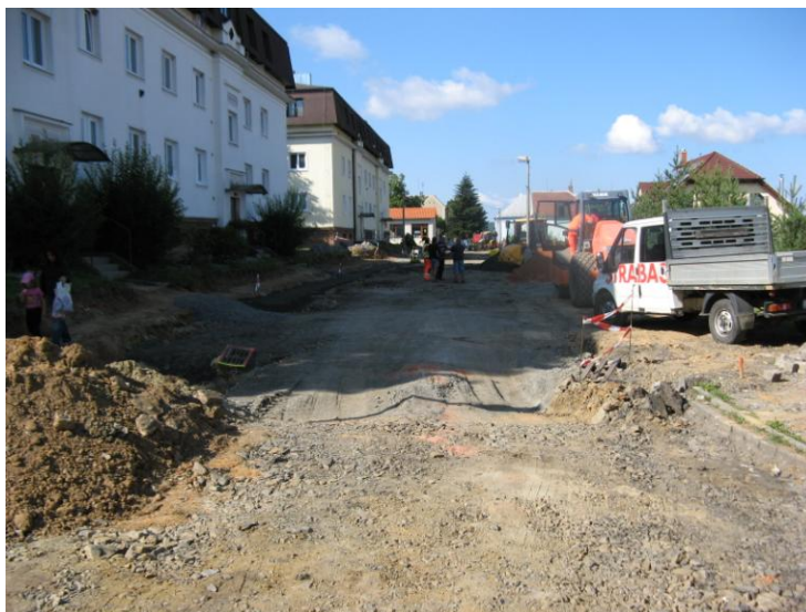
Obrázek 6 Průběh stavebních prací rekonstrukce ulic Táborová a Sokolovská
