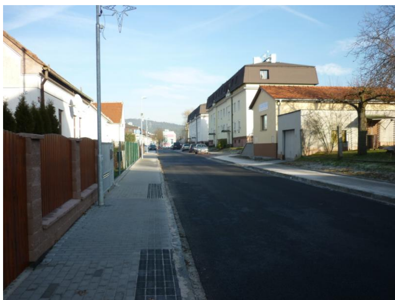
Obrázek 7 Výsledný stav rekonstrukce ulic Táborová a Sokolovská
