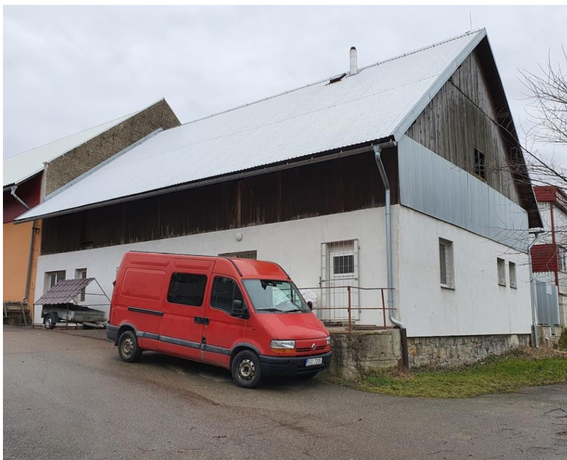
Obr. 32 Exteriér výrobní dílny.
