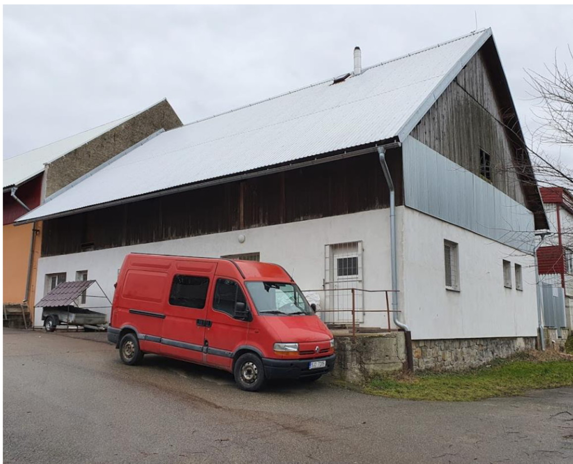
Obr. 32 Exteriér výrobní dílny.
