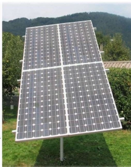
Obrázek 23 – Pohled na FV panely na natáčecím zařízení [67]
