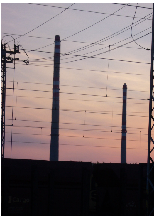
Obr. 21 Teplárna Otrokovice (zdroj: vlastní foto)
