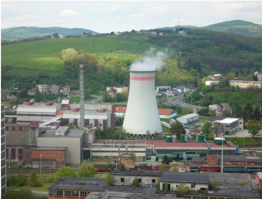
Obr. 17 Teplárna Zlín (zdroj:vlastní foto)
