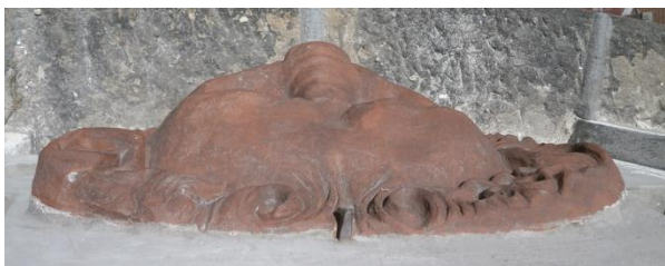
Obr. 121. Detail ukotvení maskaróna na balustrádě ochozu zámecké věže českokrumlovského zámku
