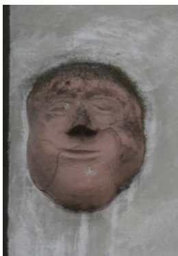
Obr. 124. Detail jednoho z kamenných maskarónů z východního průčelí (foto: autor)
