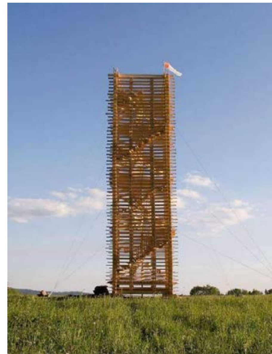
Obr 59 Věž Tower Scholzberg, Maxov, zdroj: www.archiweb.cz
