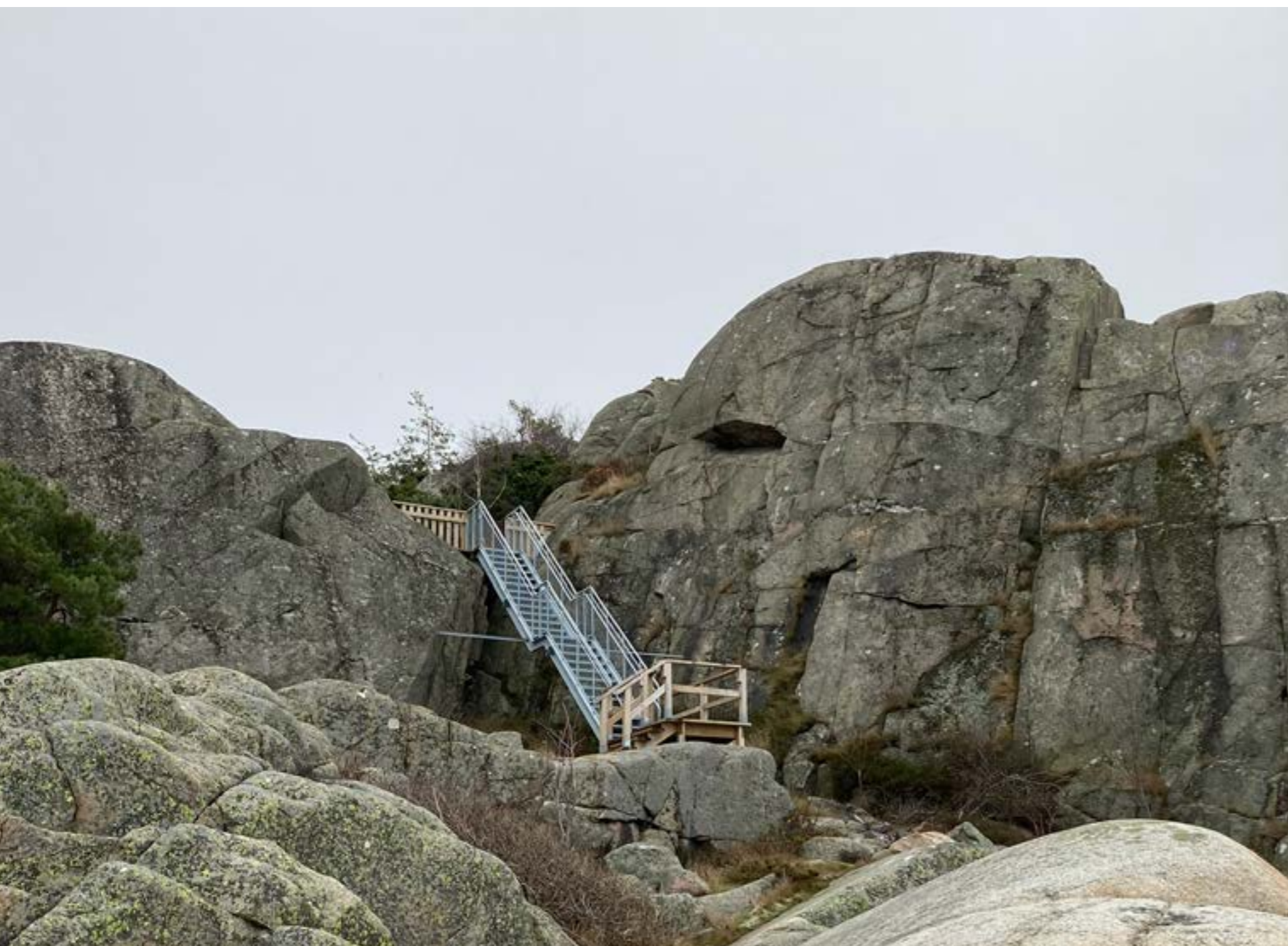
Obr 48 Přístup k moři, Göteborg, Švédsko, zdroj: autor práce
