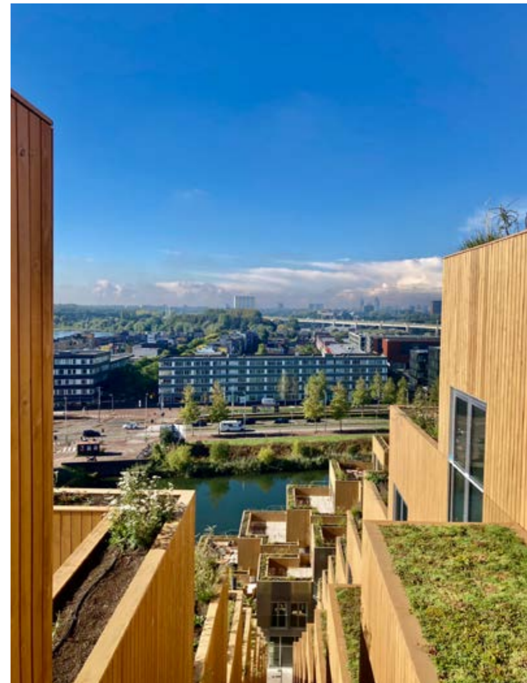
Obr. 19 Zelené střechy Sluishuis, Holandsko, zdroj: autor práce
