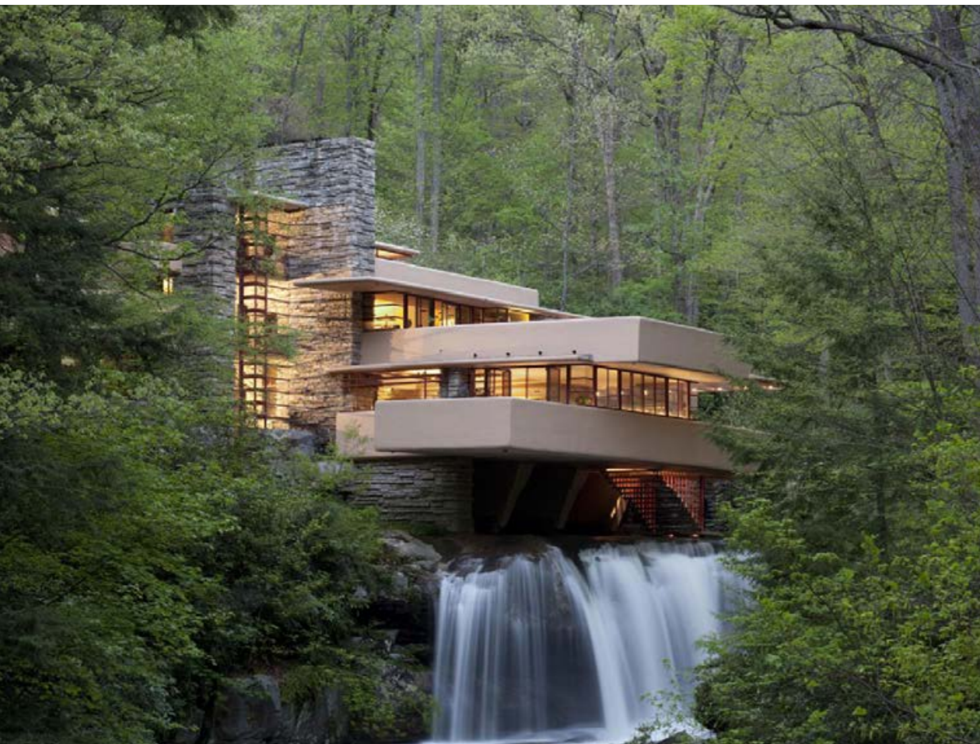
Obr. 14 Falling Water, Pensylvánie USA, zdroj: www.franklloydwright.org
