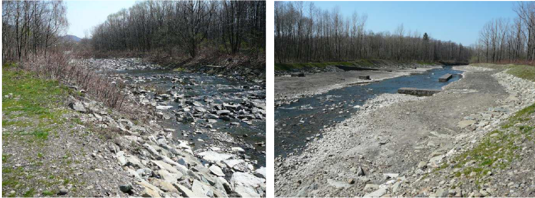
Obr. 7.1 Na levém obrázku protiproudni pohled na balvanitý skluz, na pravém obrázku poproudni pohled na spádový stupeň s rozmístěnými výhony z drátokamene (foto Pařílková, duben 2007)
