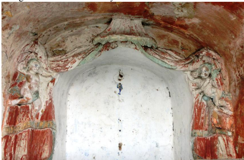
Fotografie č. 79/B – Detail výklenku
