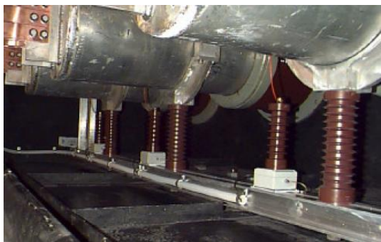
Obr. č.9 a 10 Vazební kondenzátory, instalace – katalogový pohled
