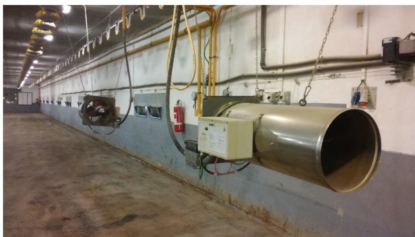
Obrázek 13 - Dvojice přímotopů zavěšených na stropě haly. Zdroj: autor
