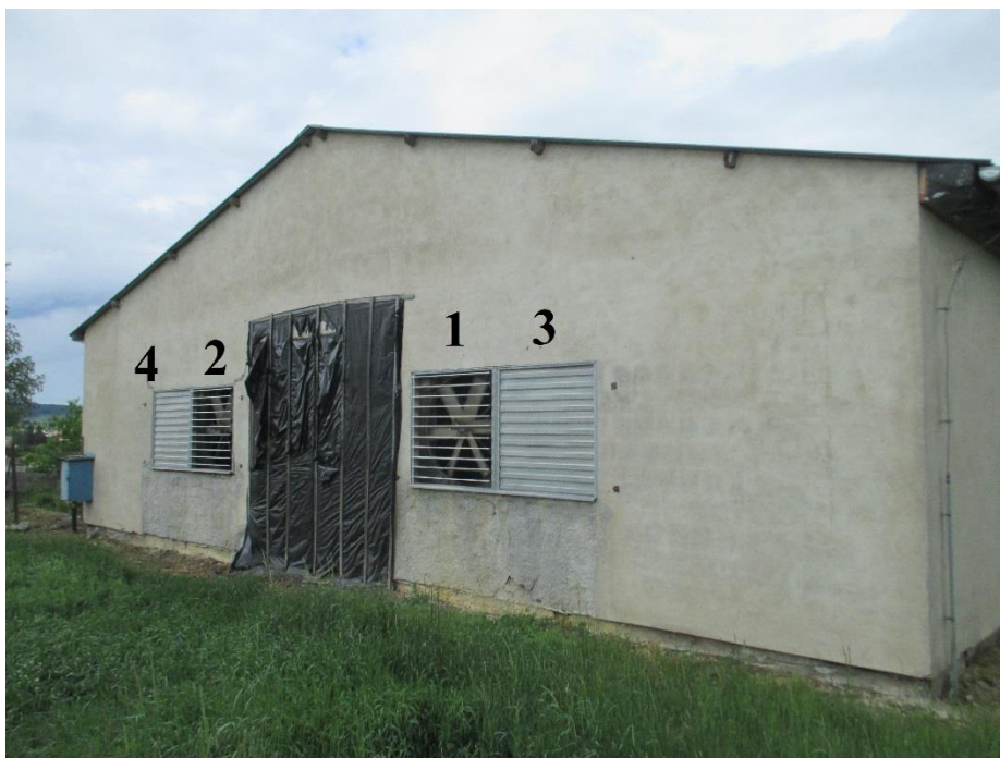
Obrázek 12 - Pohled na zadní stranu objektu s číselným označením ventilátorů. Zdroj: autor
