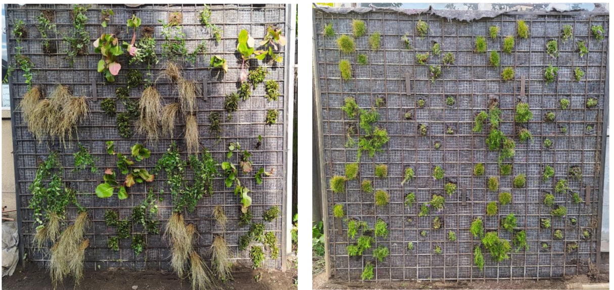
Obrázek č. 2: Stav stěny ve stínu a na slunci po výsadbě trvalek Foto: Julie Stiburková 2021
