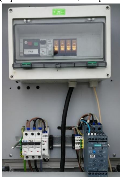
Obrázek 25 – Ovládací sloupek pro čerpadlo ve studni
