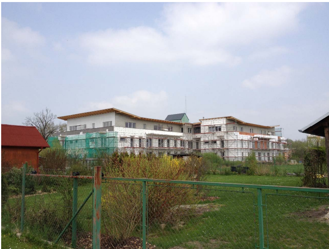
Obrázek 3-6b Fotografie zateplování stavby [vlastní]
