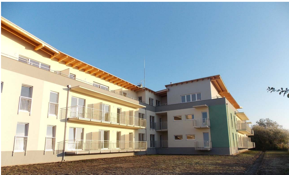
Obrázek 3-6d Fotografie dokončené stavby [vlastní]
