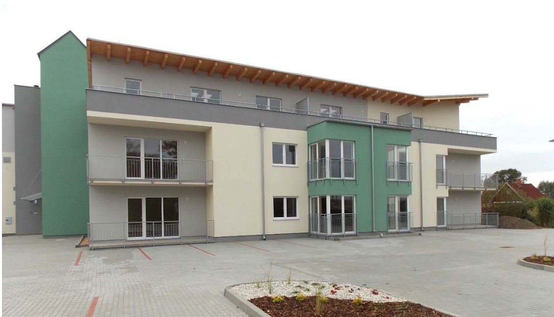
Obrázek 3-6c Fotografie dokončené stavby [vlastní]
