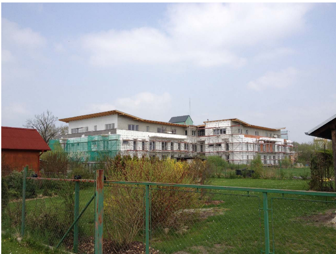
Obrázek 3-6b Fotografie zateplování stavby [vlastní]
