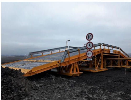
Obr. 4 Přejezd přes dopravník [8]
