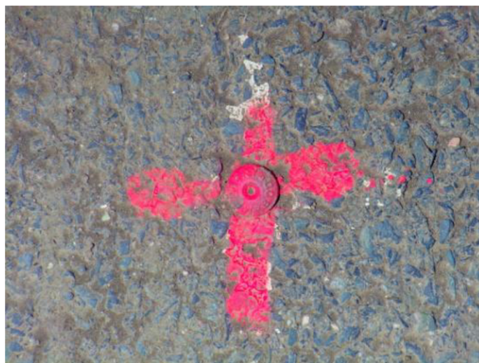
Obrázok č. 12 Ukážka stabilizácie bodov nivelačného profilu (autor)
