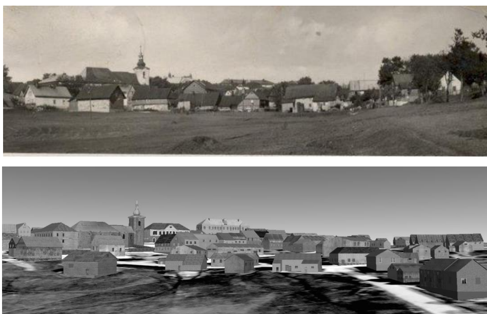
Obr. 55 Porovnání historické fotografie (nahore) a vytvořeného 3D modelu obce Čistá (dole) (Autor: P. Dědková)
