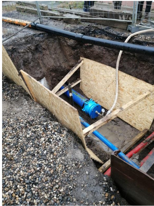
Obr. 24 – Foto startovací jámy při tlakové zkoušce
