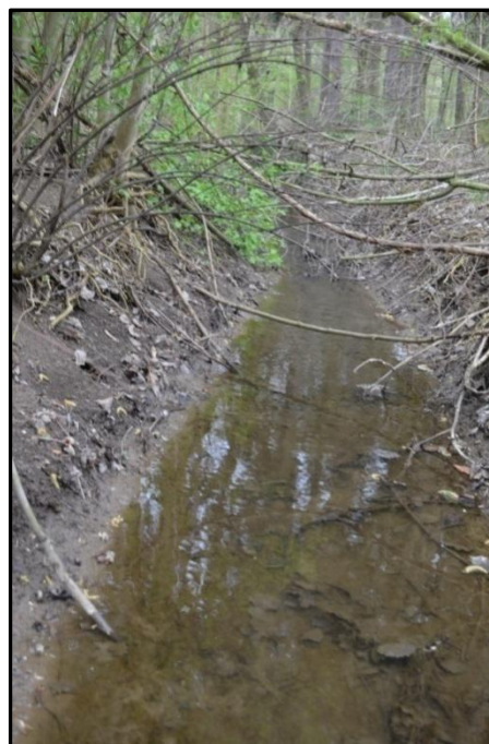
Obr. 18 – Úsek Svep_1, stržené břehy. Vlastní foto.
