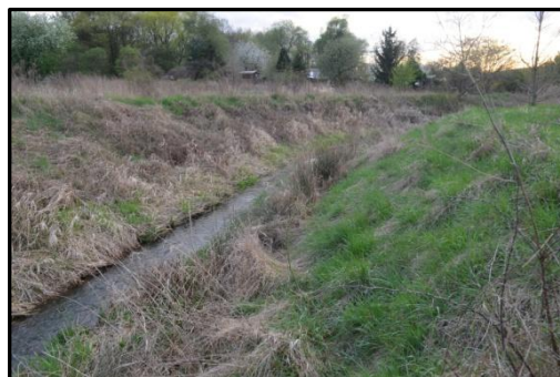
Obr. 27 – Napřímené koryto, dno tvořeno kamennou dlažbou, úsek Svej_5. Vlastní foto.
