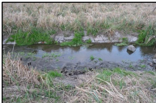
Obr. 30 – Zpevnění břehu kamennou dlažbou, úsek Svezp_6. Vlastní foto.
