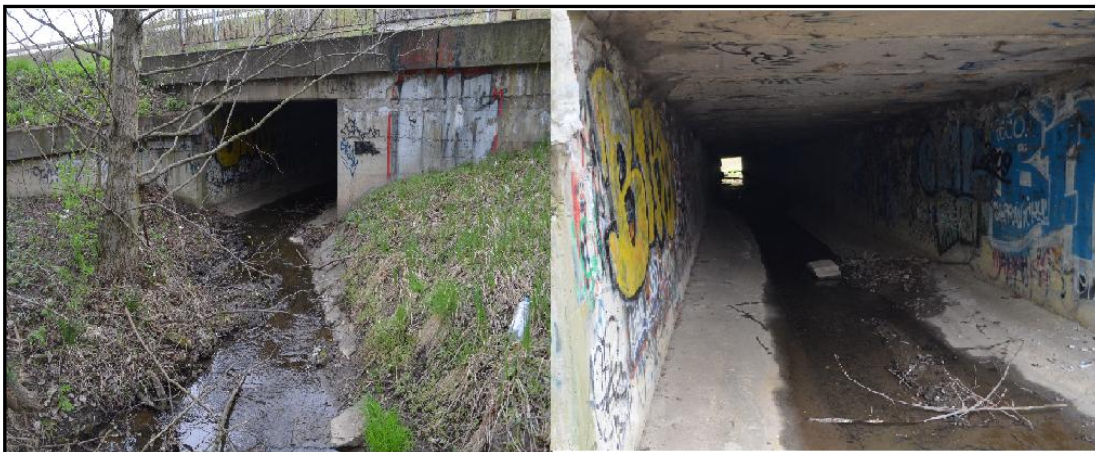
Obr. 5 - Svěpravický potok svedený pod silnicí Olomoucká. Vlastní foto.
