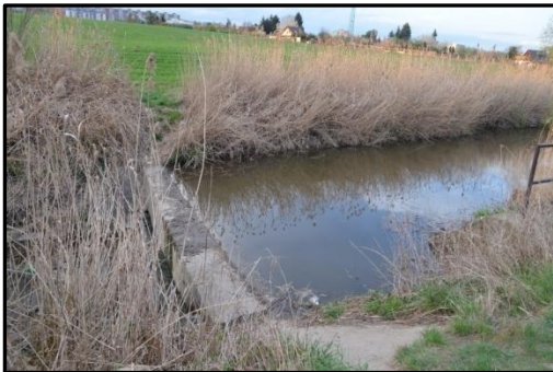
Obr. 24 – Oblast vzduť, úsek Svej_5. Vlastní foto
