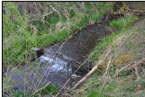
Obr. 22 – Stupeň na vybetovaném korytu, úsek Svej_3. Vlastní foto.
