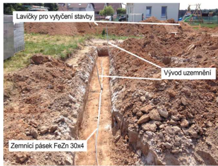
Obr. 38 Uložení zemnicího pásku , zdroj: [6]
