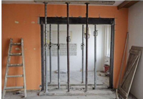
Obr. 83 Podepření stropu, zdroj: [37]
