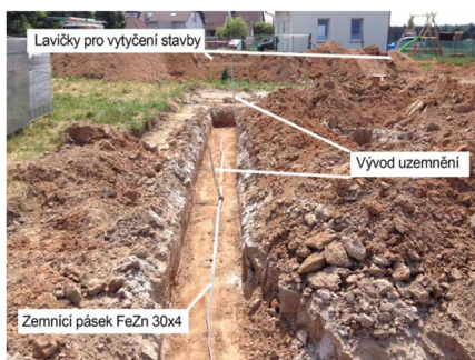
Obr. 38 Uložení zemnicího pásku , zdroj: [6]
