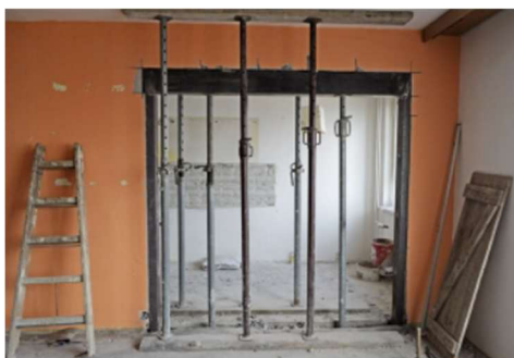
Obr. 83 Podepření stropu, zdroj: [37]
