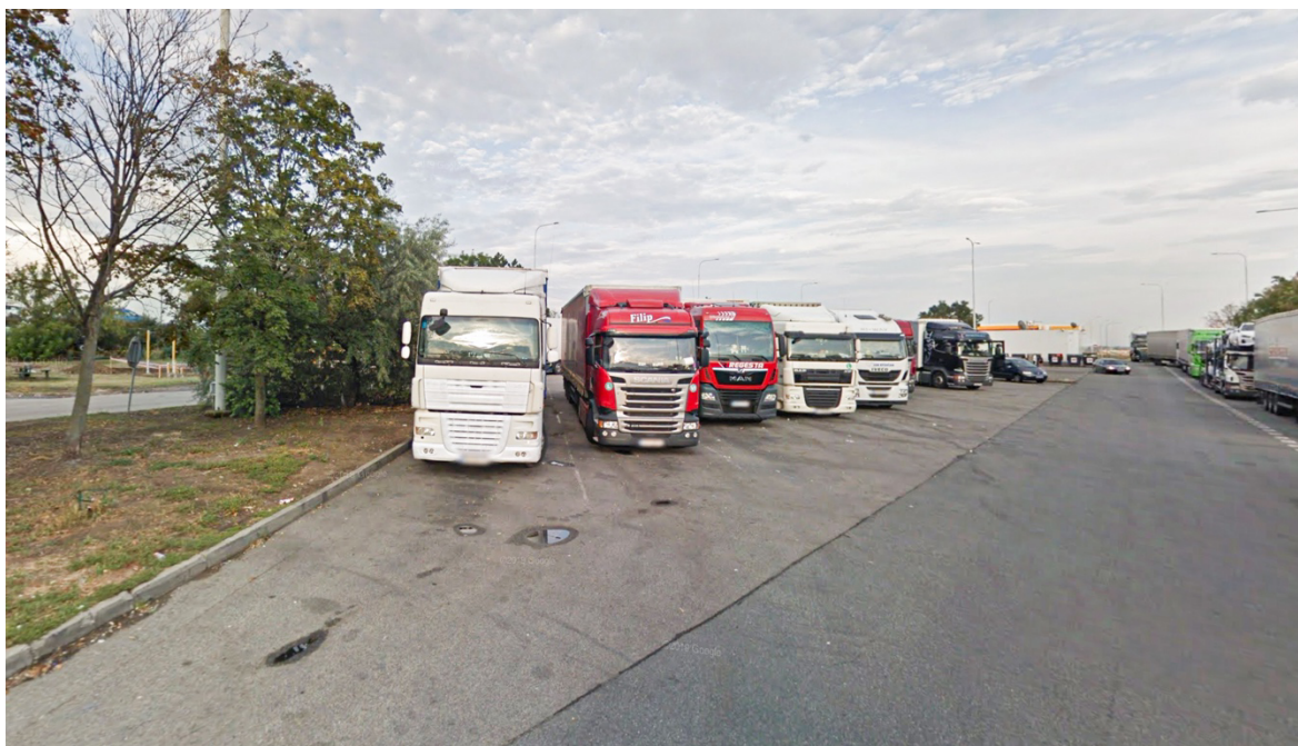
Obrázek 18: Dálniční odpočívka Ladná před rekonstrukcí. Je zde vidět dříve provedená oprava asfaltového krytu na příjezdových komunikacích (Google Street View 2018).
