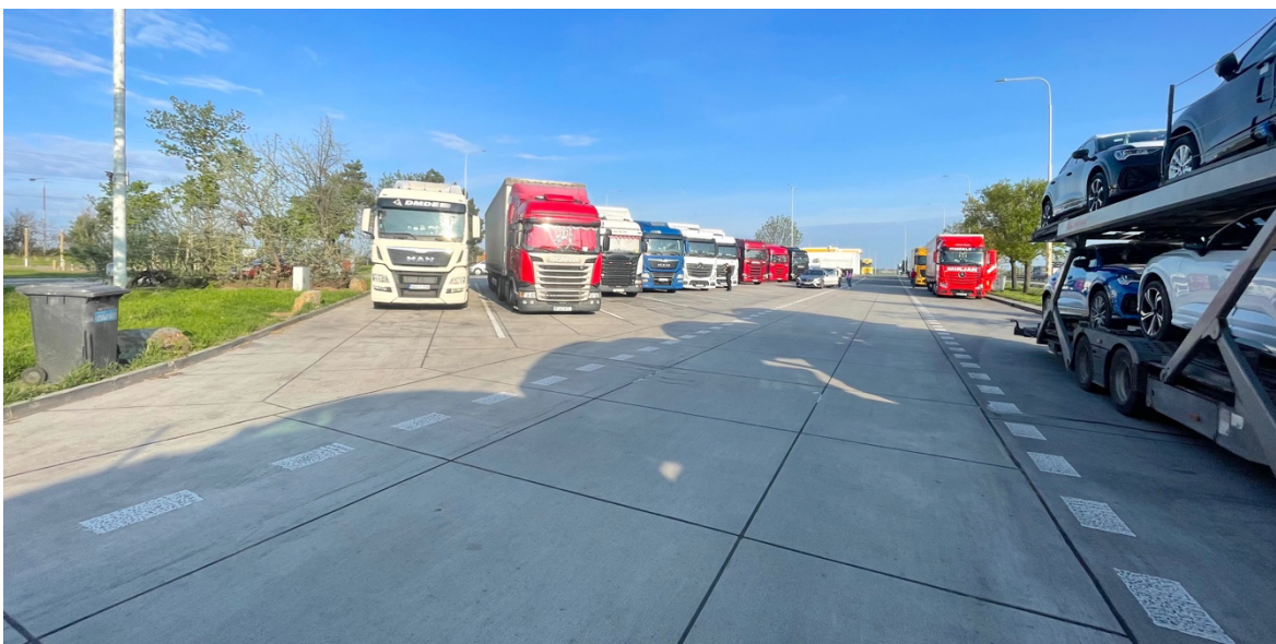
Obrázek 11: Zrekonstruovaná dálniční odpočívka Ladná metodou TWT.
