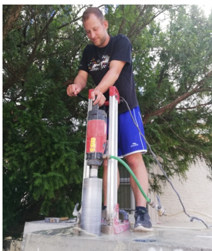
Obrázek 44: Vrtání jádrovou vrtačkou Hilty DD 130.
