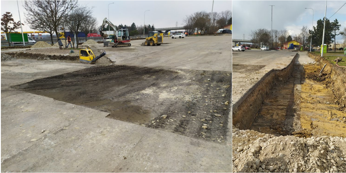
Obrázek 19: Rekonstrukce dálniční odpočívky Ladná. Vlevo – odfrézovaný povrch rekonstruovaného parkoviště. Vpravo – přechod mezi vyfrézovanou částí parkoviště pro kamiony a částí s odstraněnou skladbou vozovky, určenou pro osobní automobily [22].
