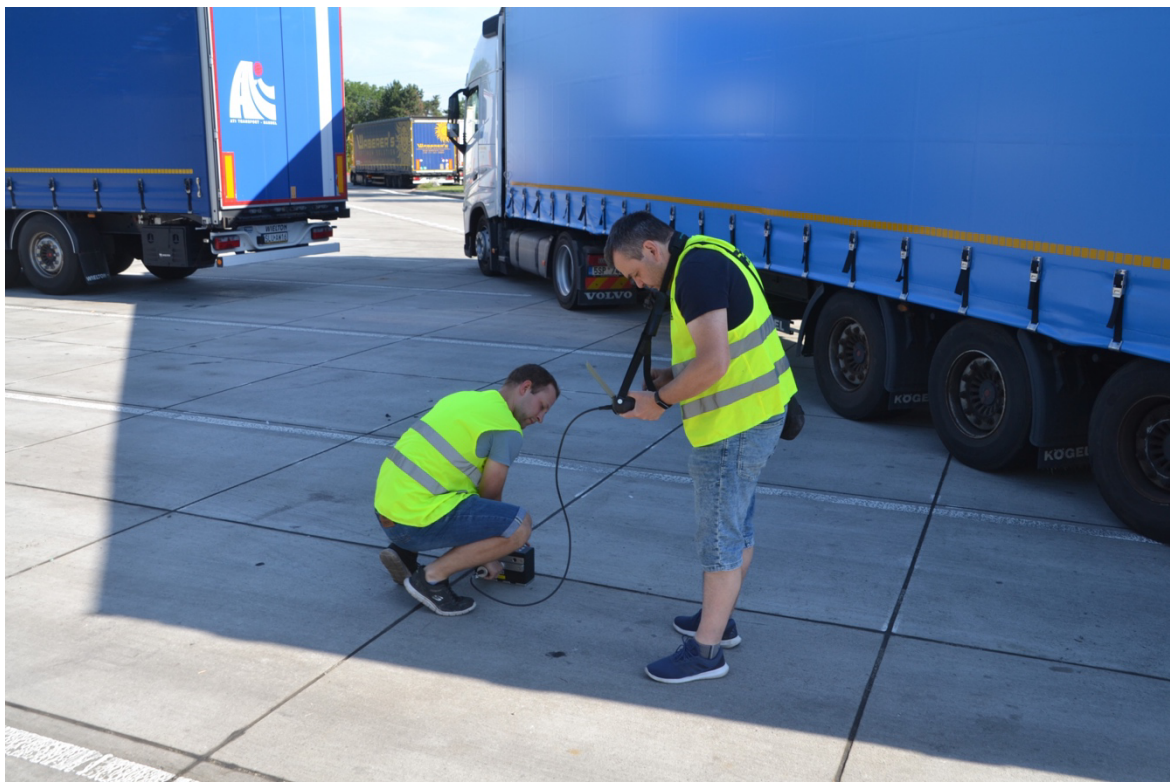
Obrázek 23: Měření in situ metodou pulse echo přístrojem Pundit 250 Array.
