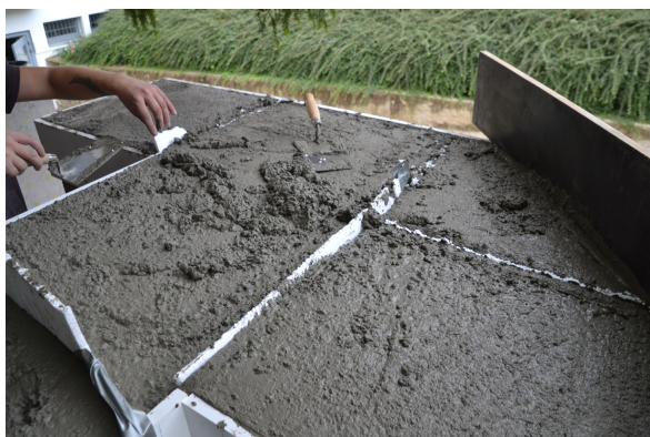
Obrázek 36: Betonáž zkušebního bloku (Jaroslav Šnědar).
