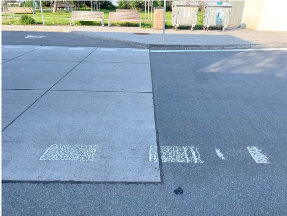
Obrázek 21: Detail napojení WT a asfaltové vozovky.
